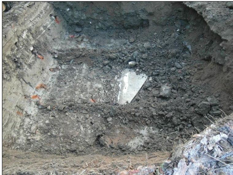
Styroxia umpisäiliön kaivannossa.
