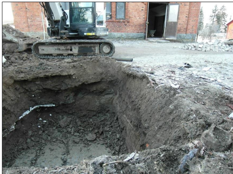
Umpisäiliön kaivanto valmiina. Styrox-kerros näkyy vasemmalla profiilissa.
