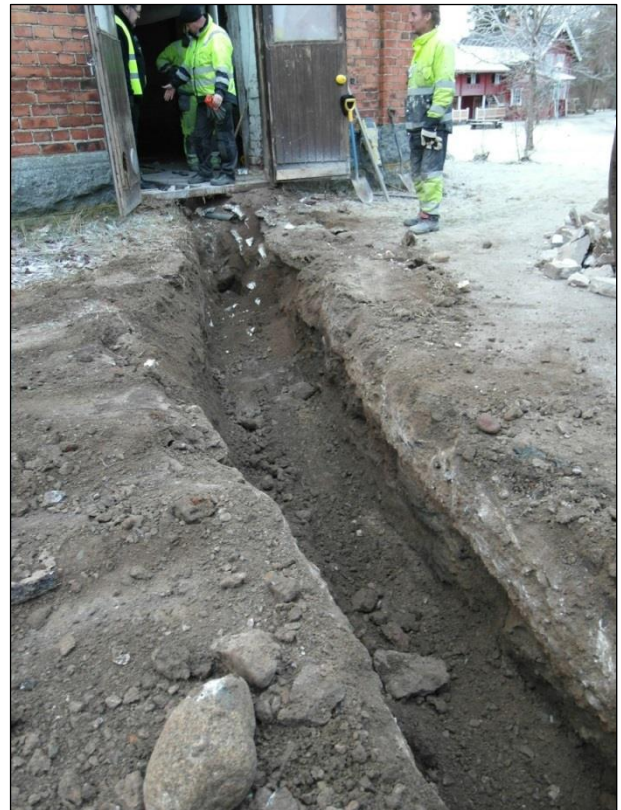
Viemärikaivantoa kuvattu lounaaseen kohti navettarakennuksen ovea.
