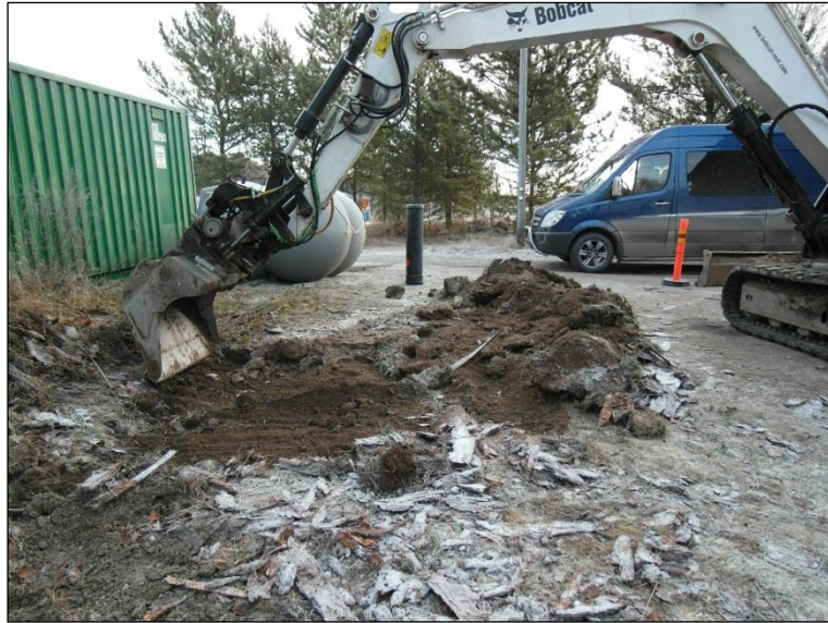
Umpisäiliön kaivannon kaivuuta.
