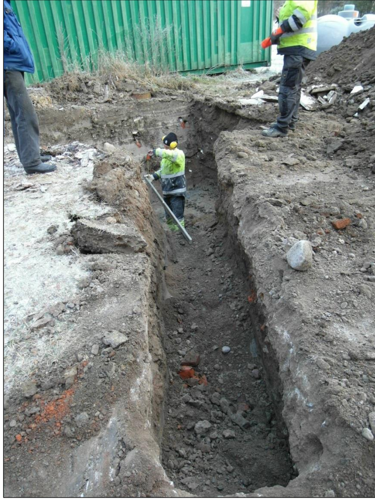
Viemärikaivantoa kuvattu lounaasta. Pinnalla ja kaivannossa punaisen tiilen palasia.
