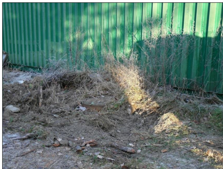
Nykyinen kaivo (heinikon alla), tulevan umpisäiliö kaivannon koillispuolella.
