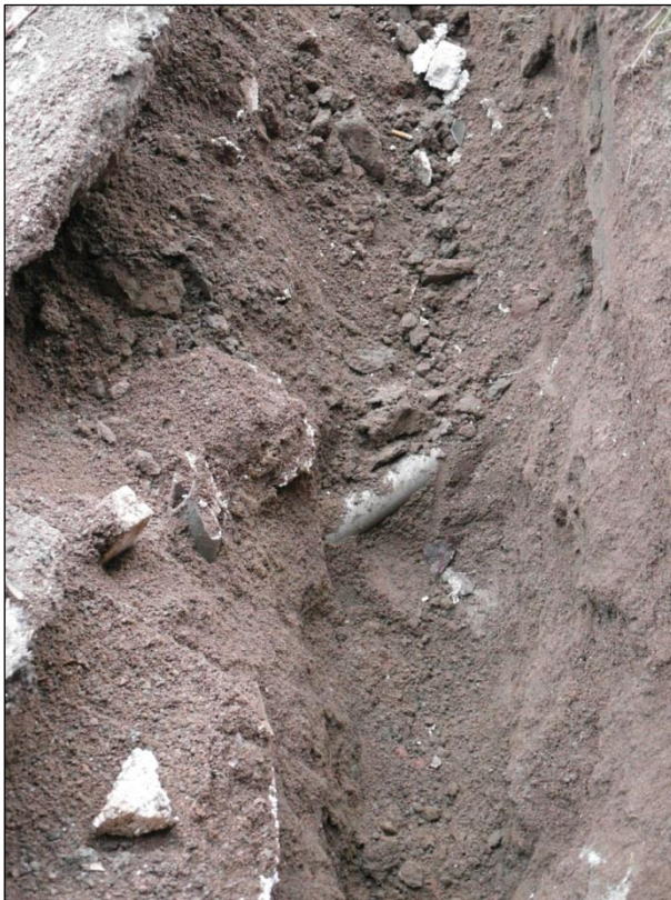
Viemärikaivantoa navetan oven kohdalla. Muoviputki näkyvissä. Kuvattuna koilliseen.
