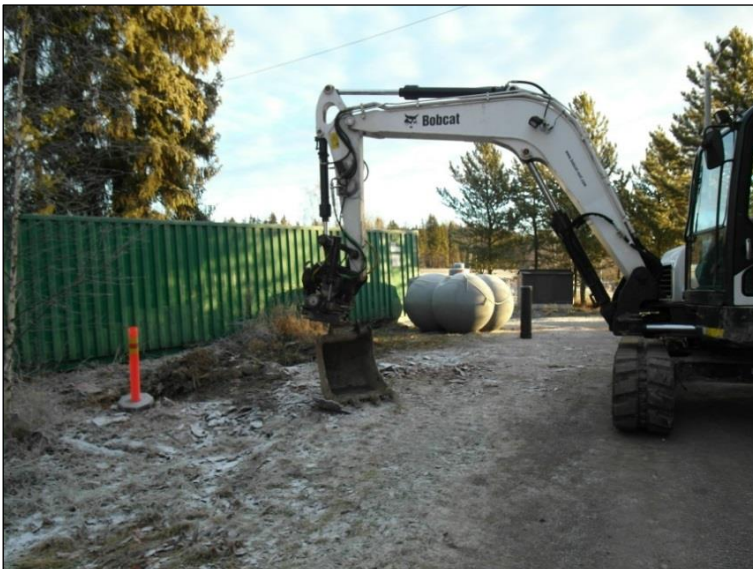
Tuleva umpisäiliön paikka kaivinkoneen kauhan kohdalla. Kuvattu lounaasta.
