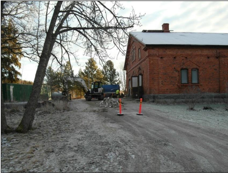
Valvonnassa kaivettava alue navettarakennuksen ja työmaakopin välissä, kaivinkoneen edustalla
